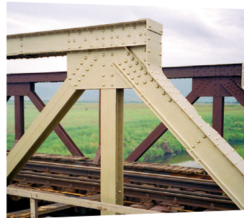
ESTRUCTURAS PARA PUENTES
