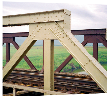
КОНСТРУКЦИИ НА МОСТОВЕ
